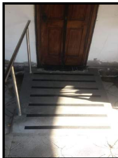
Fotografías 15 y 16 “Instalación de Barras de Seguridad y Construcción de Rampa”
