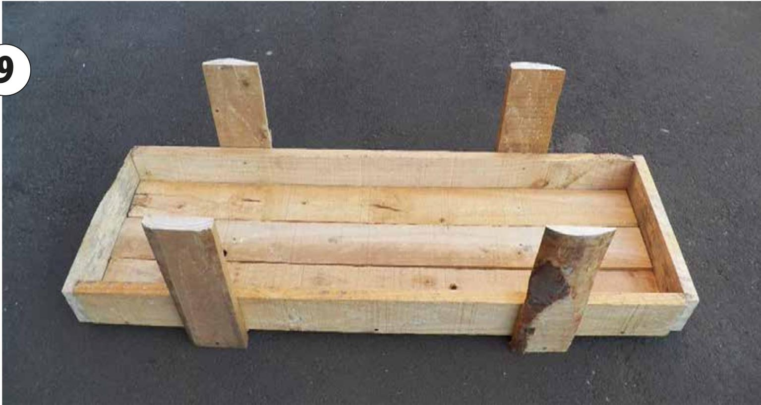
Colocamos el cajón de forma normal, y medimos 20 cms desde las puntas hacia adentro del cajón y se clavan tablitas de 22 cms (como se ve en la fotografía 9)
