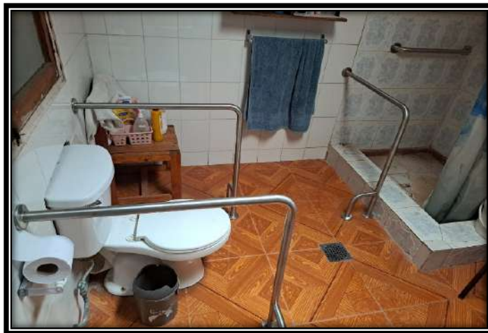
Fotografías 25 “Instalación de Barras de Seguridad en Baño”
