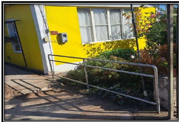
Fotografías 26 “Instalación de Baranda con Pasamanos”
