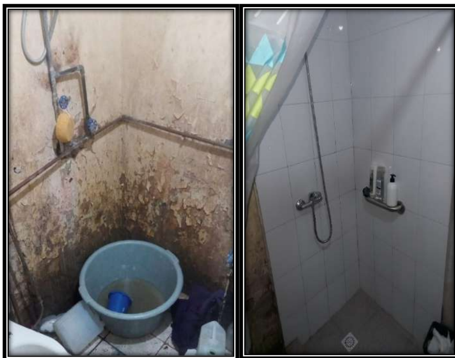
Fotografías 9 y 10 “Reparación de ducha baño, antes y después”
