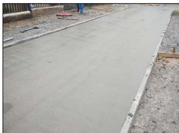
- CONSTRUCCIÓN PAVIMENTO PASAJE UNO VILLA NACIMIENTO COMUNA DE PEÑAFLORES.
