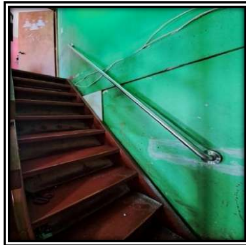
Fotografías 22 “Instalación de Pasamanos en Escalera”
