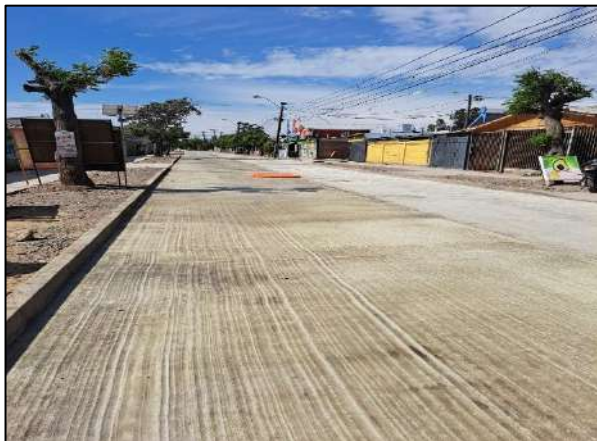
- CONSERVACIÓN PAVIMENTO CALLE LA CONCEPCIÓN PEÑAFLORES.
