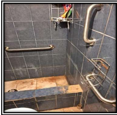
Fotografías 21 “Instalación de Barras de Seguridad en Baño”
