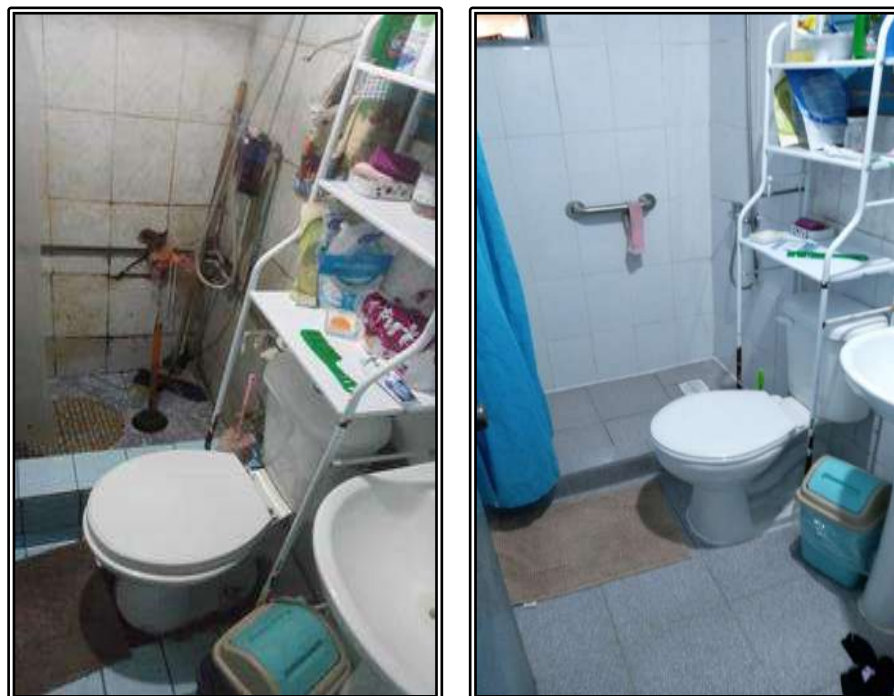
Fotografías 5 y 6 “Reparación de Recinto de Baño, antes y después”
