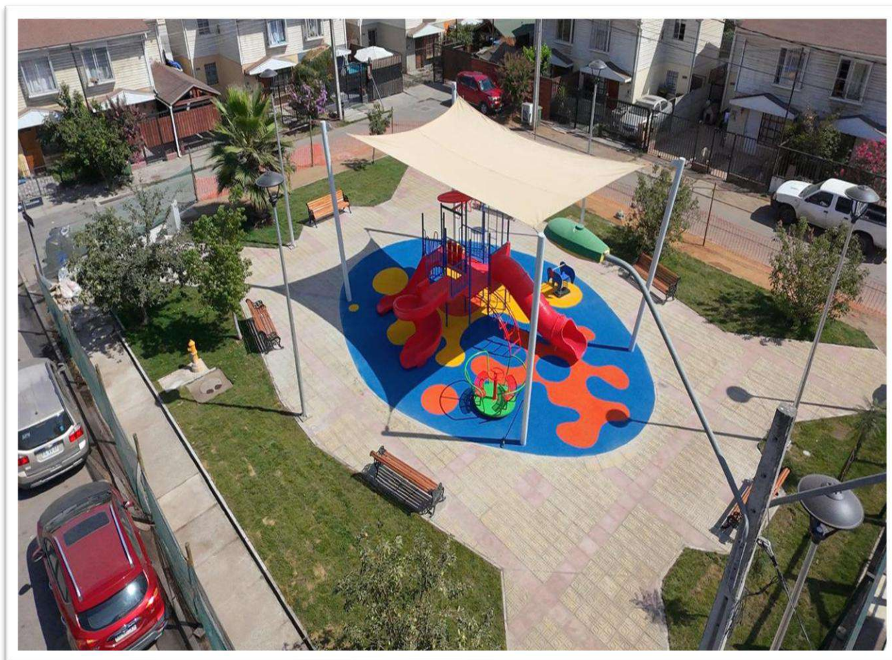
CONSTRUCCIÓN ESPACIO MULTIPROPÓSITO VILLA SALVADOR DE PEÑAFLOR
